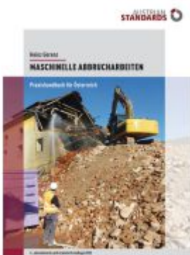
Maschinelle Abbrucharbeiten Ladenpreis: 75,90EUR
